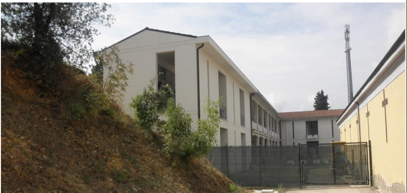
Ingresso di servizio con accesso alla parte nuova: area in cui sorgerà l'ampliamento
